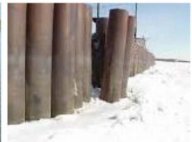
(f) Bulkhead using pipe-piles (Bethel, Alaska)
